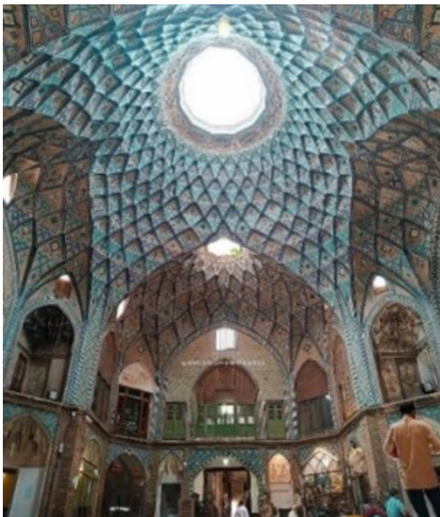
تصویر ۸. تیمچه امین الدوله کاشان (ارتفاع آسمانه، اشکوب دوم تیمچه را نیز در بر گرفته است). مأخذ: https://www.instagram.com/p/BziuKNpFVPY/?igsh=N۲۹qbmzMDA۰YW۴z
