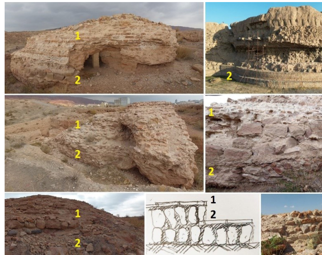
تصویر ۸. چگونگی چیدمان و کاربست آجر و سنگ و ملات آهکی برای پیشگیری از رطوبت بالا رونده در سازه پلکانی ربع رشیدی و مقایسه آن ها با برج بزرگ جنوبی، شماره ۱: آجر کاری، شماره ۲: سنگ چینی. مأخذ: نگارندگان.
