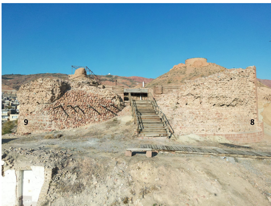
تصویر ۲. تصویری پهپادی (۱۸۰ درجه) از دروازه جنوب غربی قلعه رشیدیه: برج معروف به کبوترخانه در پشت باستیون شرقی (۸) و بازمانده دیوار گلین از تعمیرات شتابان شاه عباس صفوی در پشت باستیون غربی (۹) و روی باروی غربی دیده می‌شوند. دید از جنوب به شمال. مأخذ: Ajorloo, 2025.
