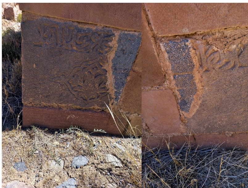
تصویر ۵. تصویری از کاربرد سنگ مزار دوره ایلخانی در هشتی دروازه جنوب غربی قلعه رشیدیه. مأخذ: Ajorloo, 2025.
